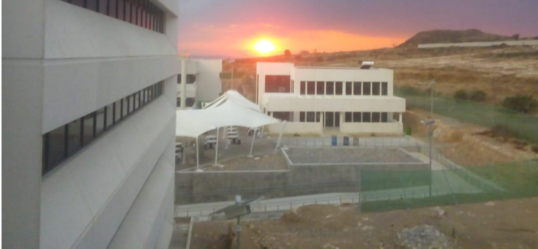
Figura 3.9.- Vista de la cafetería
