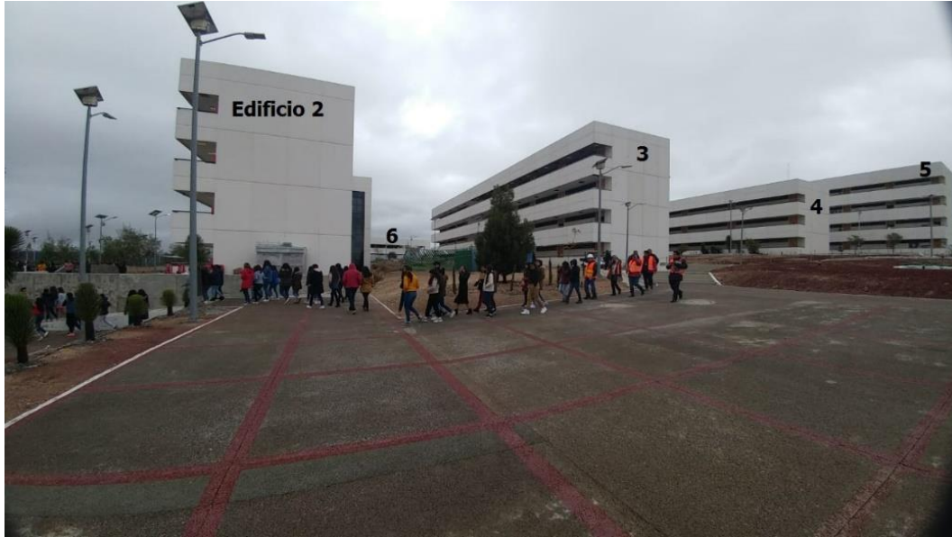
Figura 3.5.- Panorámica de los edificios 2 al 5 en primer plano, edificio 6 al fondo
