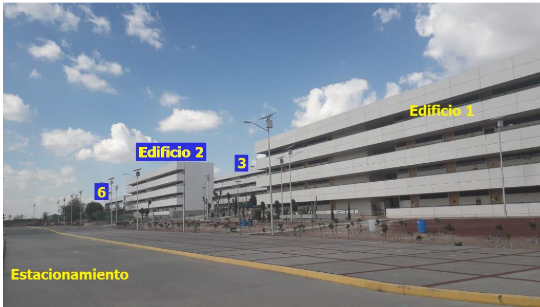
Figura 3.3.- Panorámica de los edificios 1, 2, 3 y 6 al fondo
