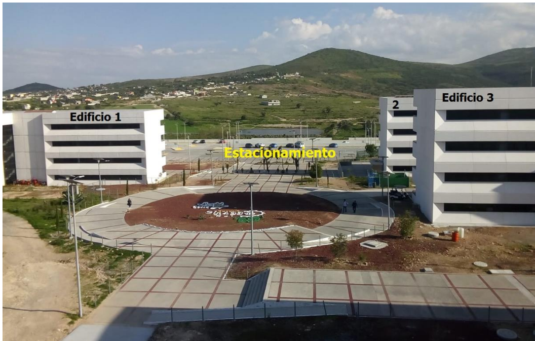
Figura 3.6.- Panorámica edificios 1 al 3 y primer nivel del estacionamiento
